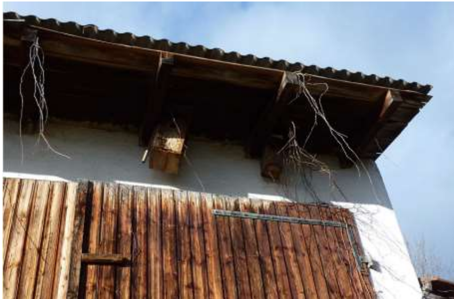
Abb. 7: Alte Starenkästen unter dem Dach der Garage .
